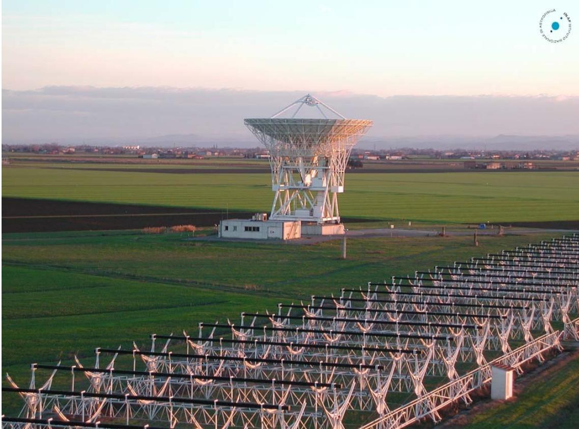
*Illustrazione 1.2: I due radiotelescolpi dell'osservatorio di Medicina(BO):la Parabola da 32 metri(in alto) e la Croce del Nord(in basso).*
