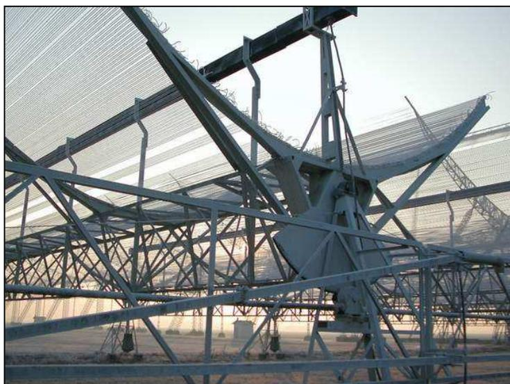
**Figura 1.2.3** – Particolare dei cavi di acciaio costituenti gli specchi
