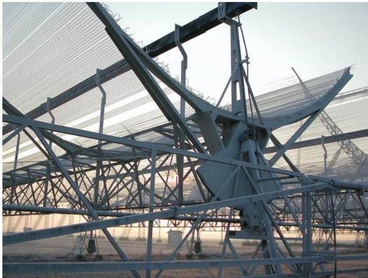
Figura 1.5: Particolare del riflettore di una delle antenne che compongono il ramo N-S. In questa foto i fili d'acciaio sono ben visibili e appaiono più grossi di quanto non lo siano nella realtà a causa della brina.
