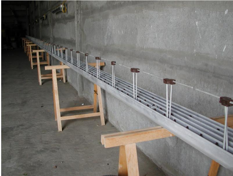
Figura 1.15: La linea focale viene preparata per l'installazione dei LNA.
