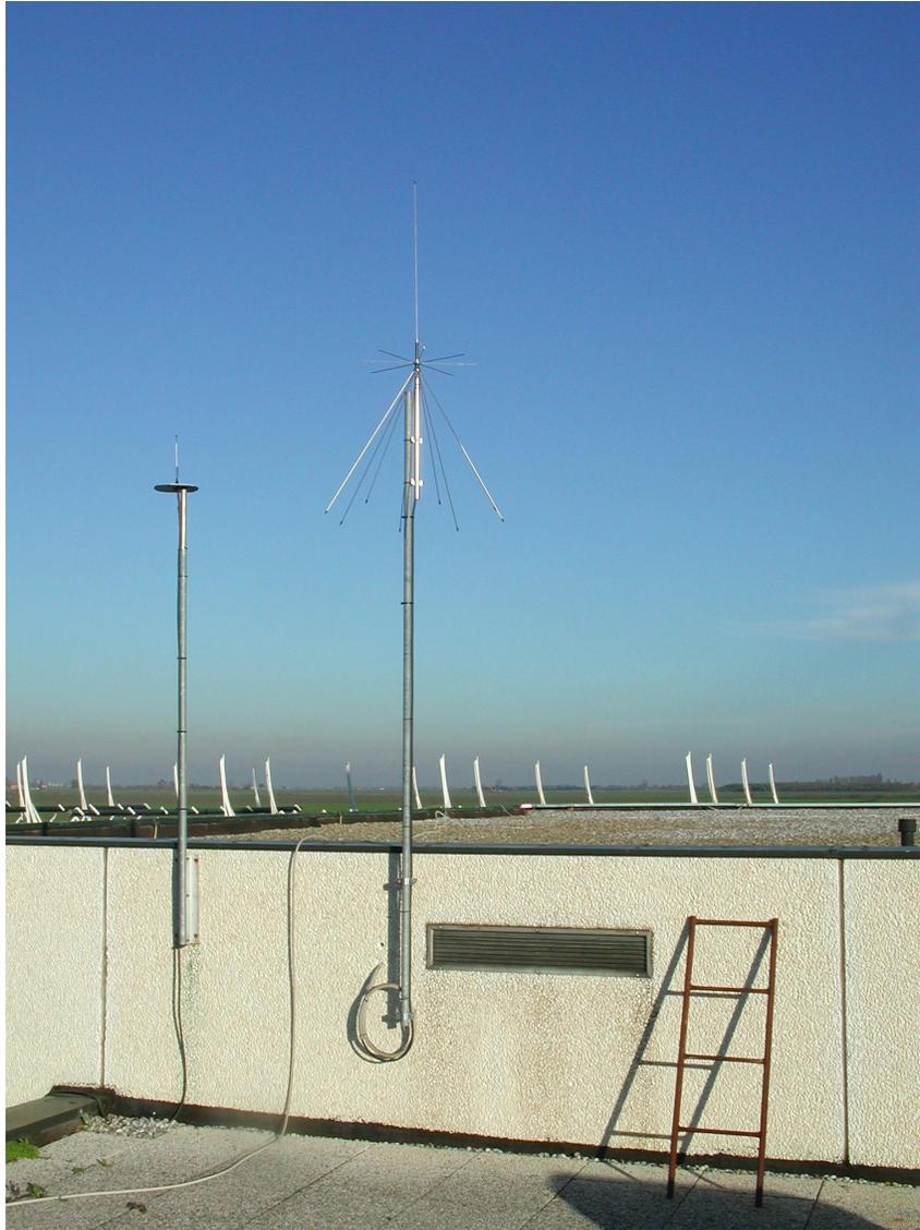
Figura 5.5: L'antenna omnidirezionale a larga banda utilizzata per ricavare il segnale ausiliario.
