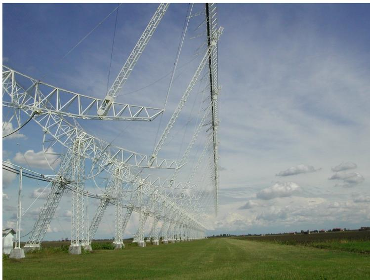
Figura 1.2: La grande antenna cilindro-parabolica che costituisce il ramo E-W della *Croce del Nord*.
