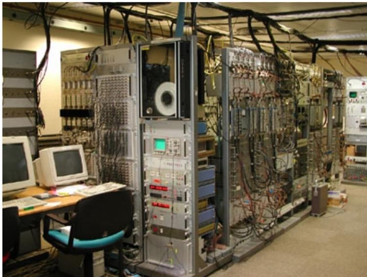
Figura 1.10: La stanza del ricevitore della *Croce del Nord*: in essa convivono apparecchiature realizzate negli anni '60 e '70 (lettore a carta, sistema di calibrazione. . .) e nei giorni nostri (spettrometro digitale, sistema PULSAR. . .).
